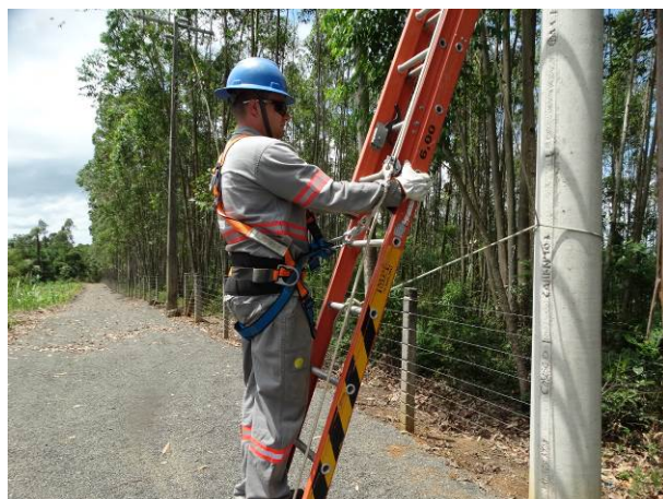
Figura 37 – Subida na escada
