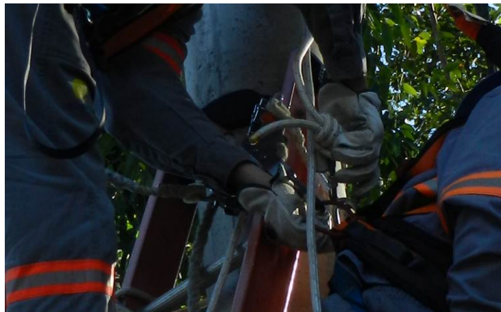
Figura 49 – Engate do mosquetão no trava-quedas do acidentado
