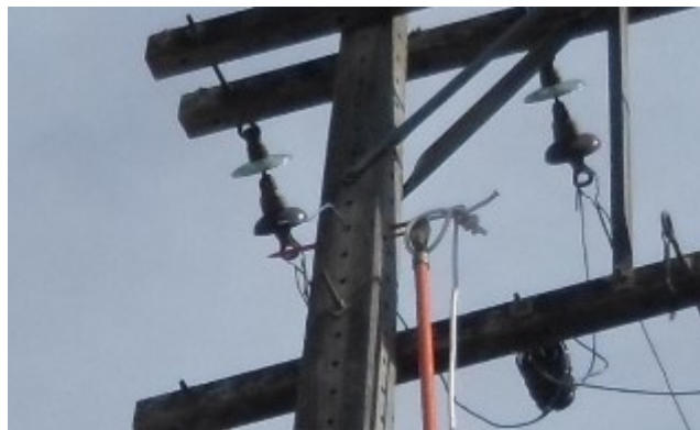
Figura 31 – Instalação do agulhão no poste
