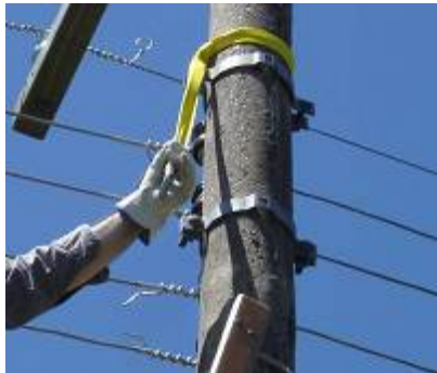
Figura 16 – Ancoragem com fita e mosquetão no poste
