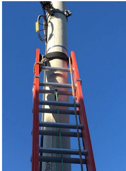
Figura 23 – Posicionamento da escada
