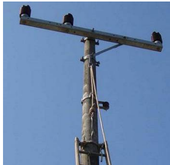
Figura 17 – Ancoragem na ferragem do poste
