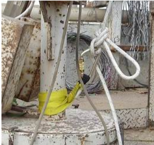
Figura 11 – Ponto de ancoragem
