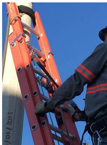
Figura 24 – Sistema utilizando talabarte tipo Y (Trocar a foto)
