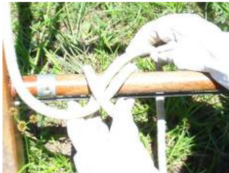
Figura 20 – Ajuste do nó fiel na base da escada
