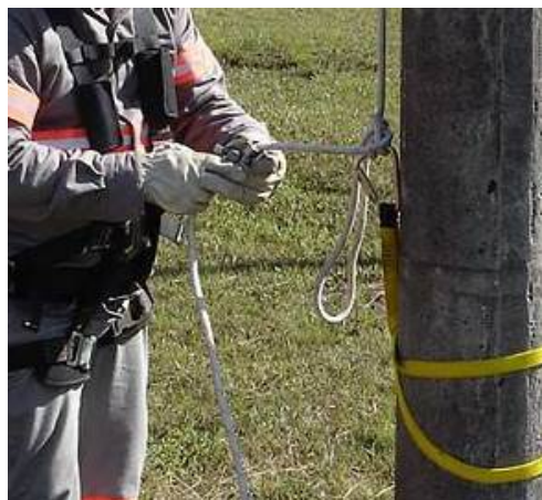
Figura 39 – Instalação do trava-quedas
