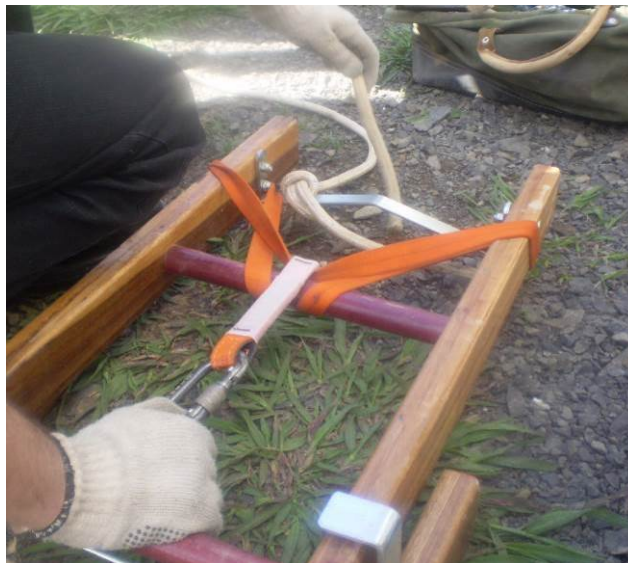
Figura 12 – Instalação do ponto de ancoragem
