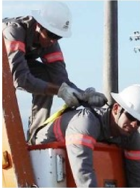
Figura 44 – Retirada do acidentado
